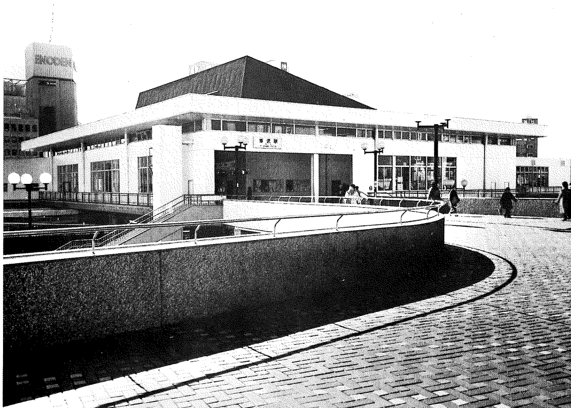
●ファイニッシャーNo. 500施工例……(国鉄・藤沢駅)
