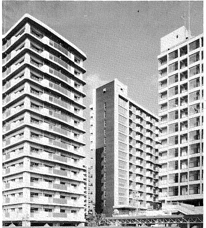
(施工例 大阪府 北緑ヶ丘公園住宅)
