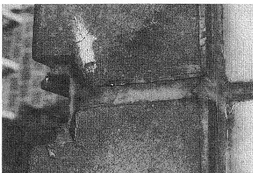
写真-4 Tビルの笠木におけるシーリング材の剝離
