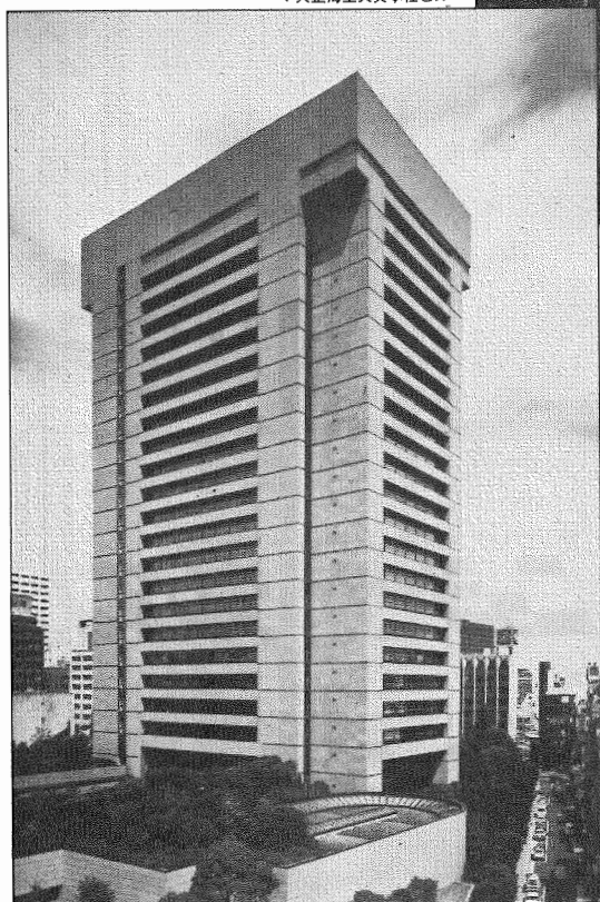
▼大正海上火災本社ビル
