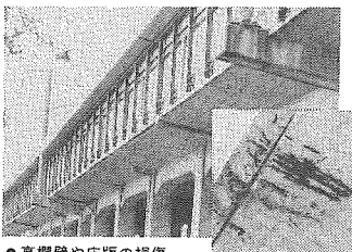
●高欄壁や床版の損傷
