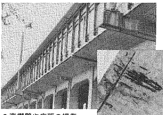
●高欄壁や床版の損傷
