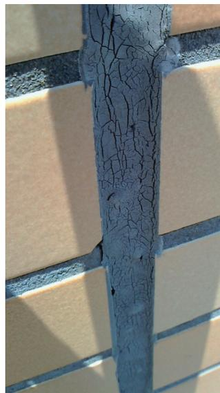
写真 16 シーリング目地のひび割れ
