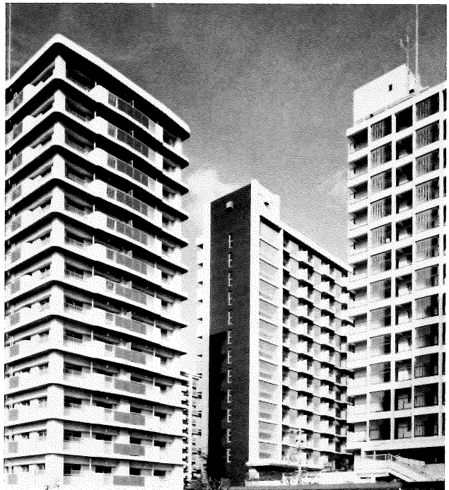
(施工例 大阪府 北緑ヶ丘公団住宅)
