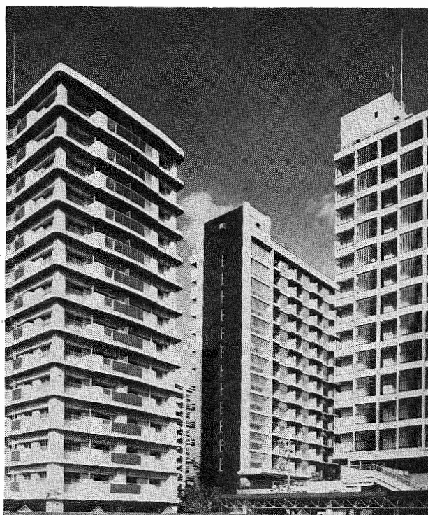
(施工例 大阪府 北緑ヶ丘公園住宅)
